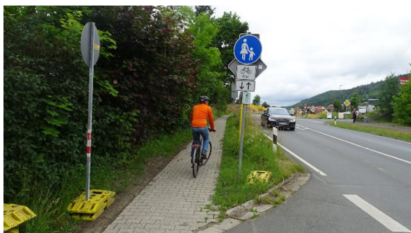
Abbildung 19: Unzureichende Sicherung des Radverkehrs: Gehweg Radfahrer frei (links; Stadtsteinach); Netzlücke: Nicht befahrbarer Netzabschnitt (rechts; Thurnau)
