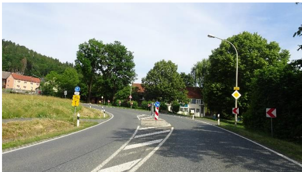
Abbildung 21: Existente bauliche Querungshilfe an der B 303 in Stadtsteinach (links) und fehlende Querungshilfe an der Limmersdorfer Straße (KU 17) in Thurnau (rechts)
