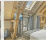
Das historische Holzgebälk konnte weitgehend erhalten werden.
