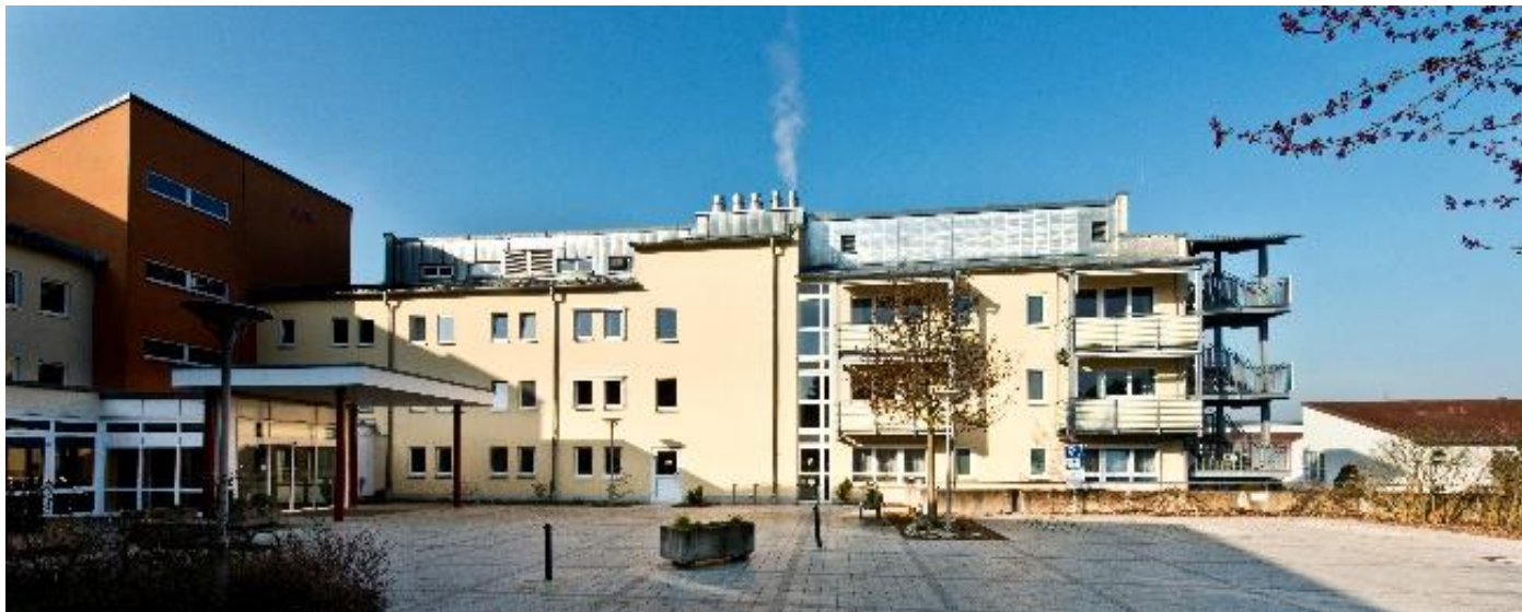
Holz-Alu-Fenster in Fassade mit Pfosten-Riegel-Konstruktion
