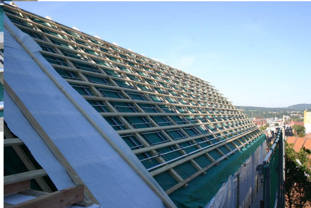
Holzkonstruktion für Ziegel
