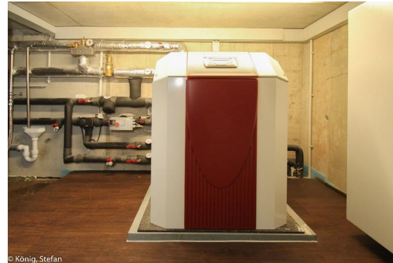
Die Wärmepumpenanlage
