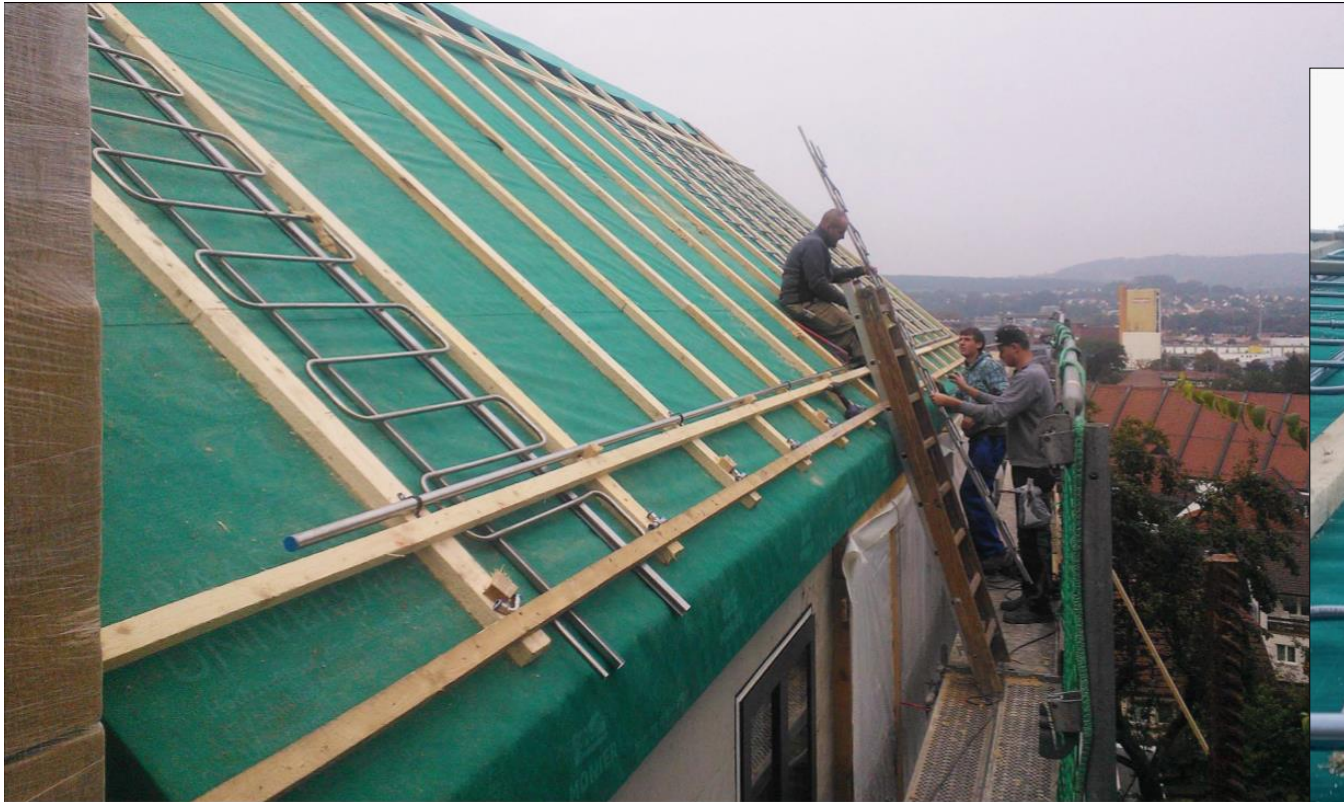
Installation der Solarregister
