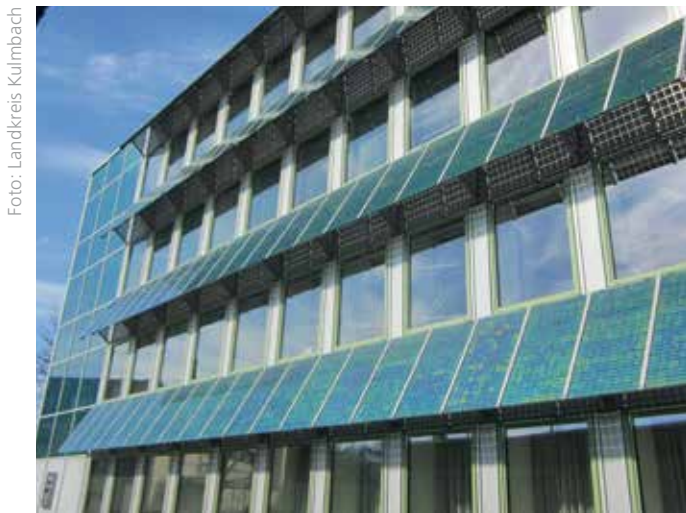
Photovoltaikfassade des Landratsamtes in Kulmbach
